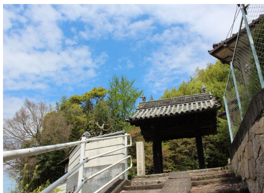
石段を上がると本瓦の薬医門
